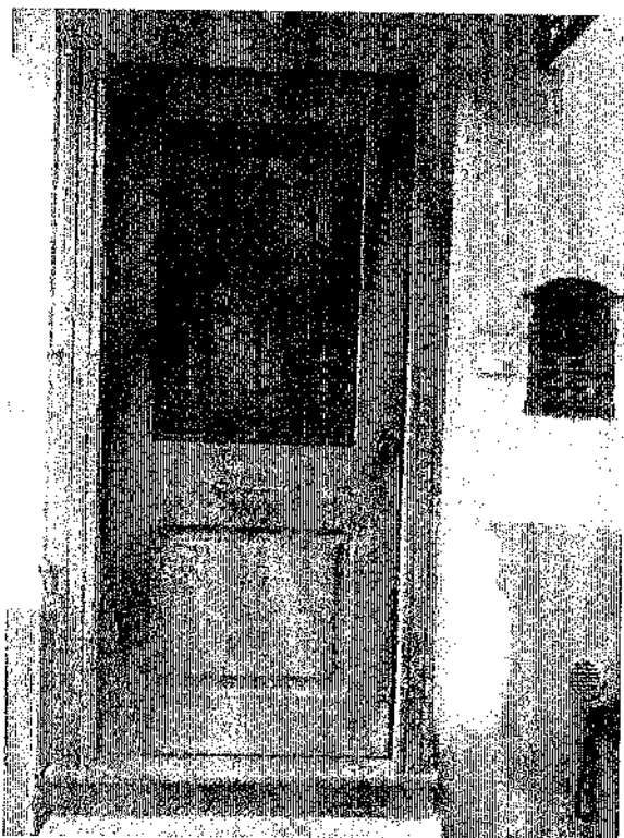
Foto n. 3) Portone dell'unità immobiliare oggetto di esecuzione in Velletri Via Santa Maria del Sangue n. 8.
